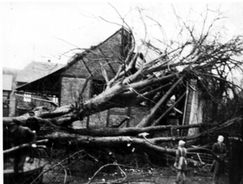
Aufräumarbeiten: Die Beseitigung der umgestürzten Linde, um die damals Hauptdurchgangsstraße wieder befahrbar zu machen.
