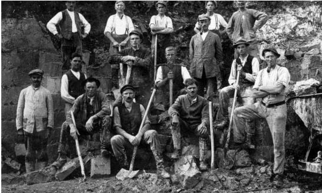
Ein Bild vom Tagebau der Grube Hermann Beilstein-. Im Vordergrund die viereckig abgestochen Tonstücke, die dann wie oben beschrieben transportiert wurden.
