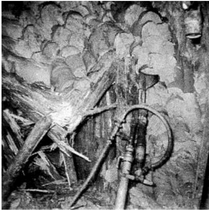
Tonebruch auf der Grube Landwehr
